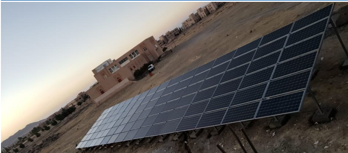
تركيب منظومة الطاقة الشمسية لبئر ارتوازية في الخزان الرئيسي بالجامعة
